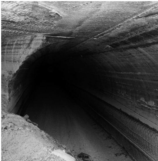
Рис. 1. Горная выработка с пролетом 3 м
