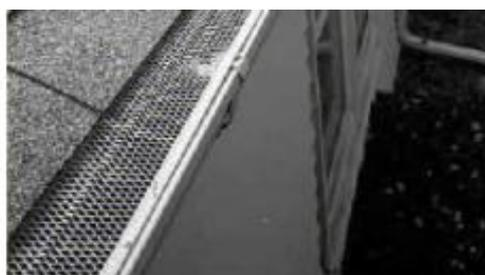
Figura III.7 - Calha perfurada no topo da caldeira para reter poluentes maiores (Mano, 2004)
