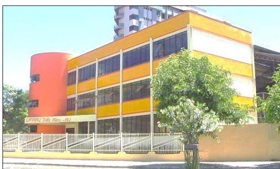
Imagem 34: Edifício anexo Colégio Walter Franklin (Fonte: Autor, 2014).
