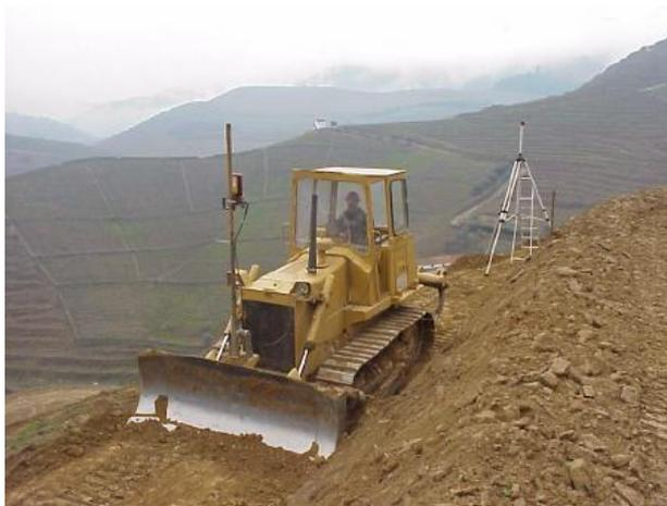
**Figura 4.** Construção de patamares através da utilização de potentes bulldozers (Magalhães, 2003a).
