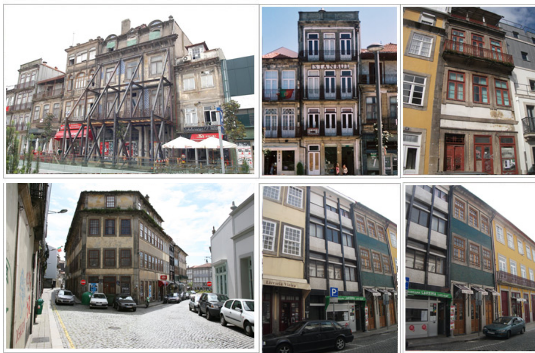
Figura 11 - Aspecto exterior dos imóveis antes da intervenção (SRU, 2005)
