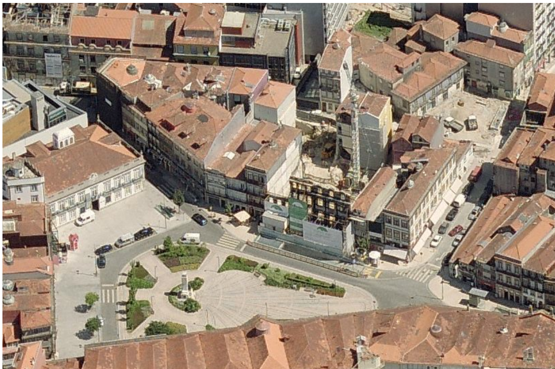
Figura 12 - Vista aérea do Quarteirão Carlos Alberto durante a intervenção (BingMaps, 2014)
