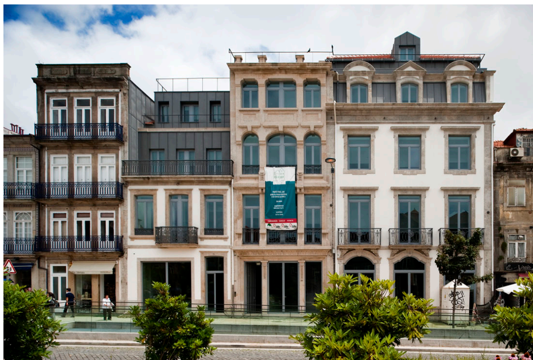
Figura 16 - Fachada virada para a Praça Carlos Alberto após a intervenção (SRU, 2007)
