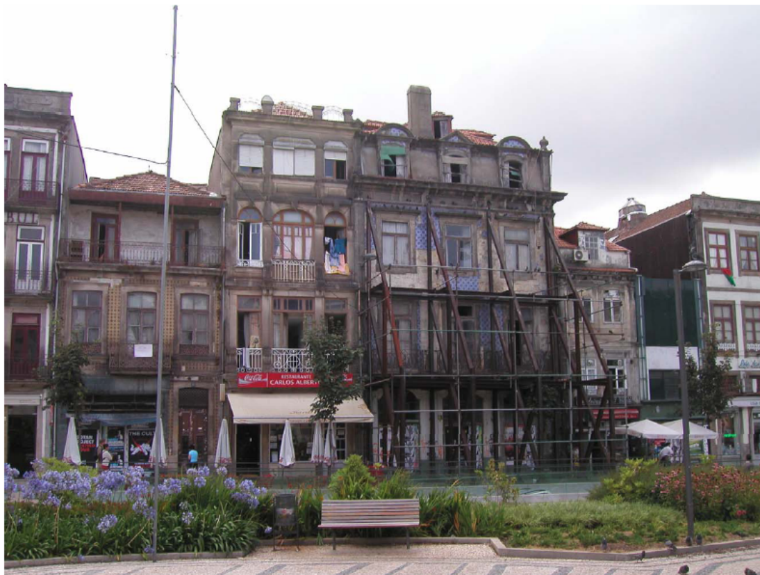
Figura 15 – Fachada virada para a Praça Carlos Alberto antes da intervenção (SRU, 2007)
