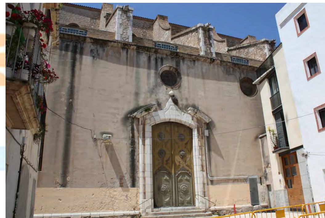
Fig. 6: Fachada c/ St. Pere
