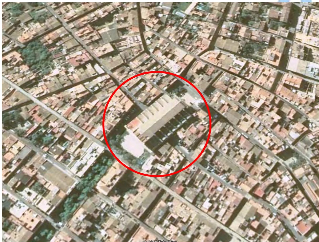
Fig. 1: Situación del edificio y su entorno
