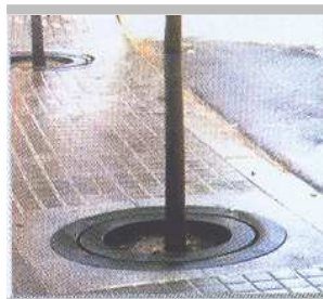
Fig. 2.2 Imatge d'una tapa escocell situada al barri del Carmel.
