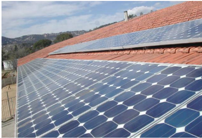
Fig. 2.5.-Elemento sobrepuesto en tejado.
