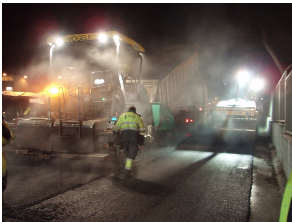
Fig.3.13 Extendido de la mezcla de los tramos III(A y B) y IV(A y B).
