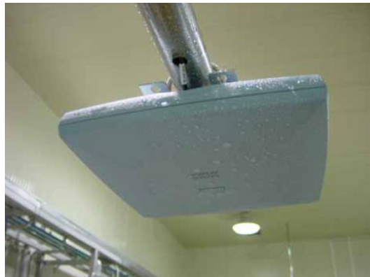
Detalle de la antena con agua tras la limpieza de la planta que se realiza a diario
