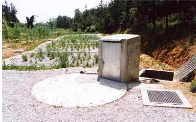
Figura 3. Exemple d'aiguamolls construïts
