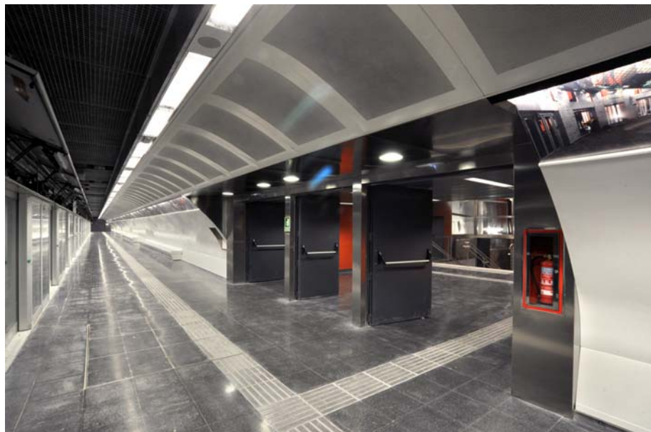
Figura 59 Portes de sectorització andana-preandana. Font: Ifercat 2009
