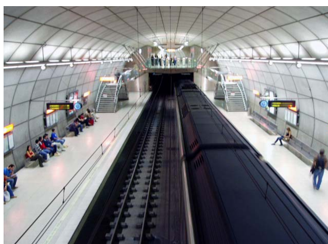
Figura 13 Estació de Metro de Bilbao. Estació subterrània. Font: Metro de Bilbao
