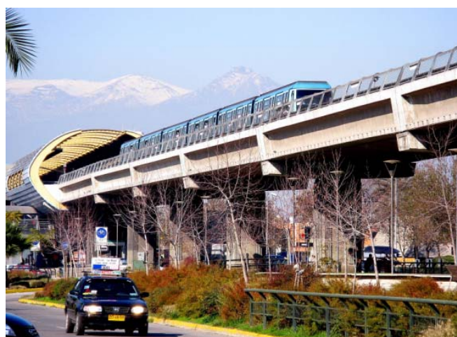
Figura 11 Exemple d'estació elevada al Metro de Santiago de Chile. Font: Ariel Cruz
