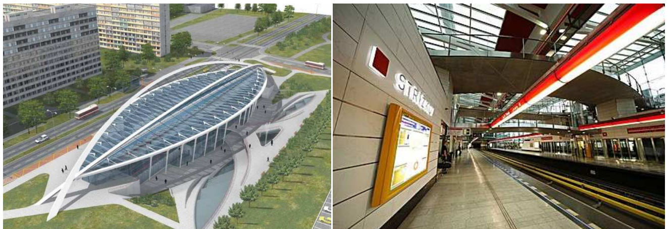
Figura 42. Nueva estación de metro Střížkov (línea C). Fuente: [w33] izquierda y [w34] derecha.
