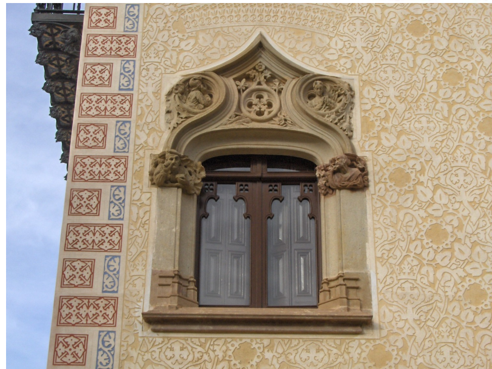
Finestra planta segona
