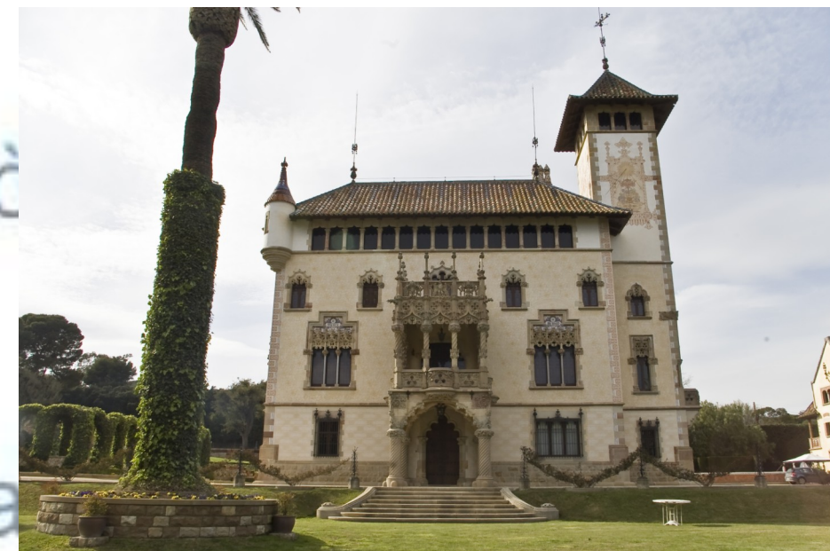
Façana principal de Casa Garí
