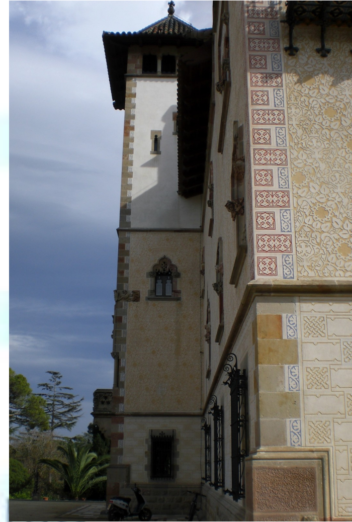
Torreó (vista façana oest)
