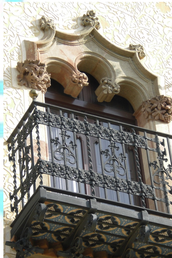
Balconera de planta segona
