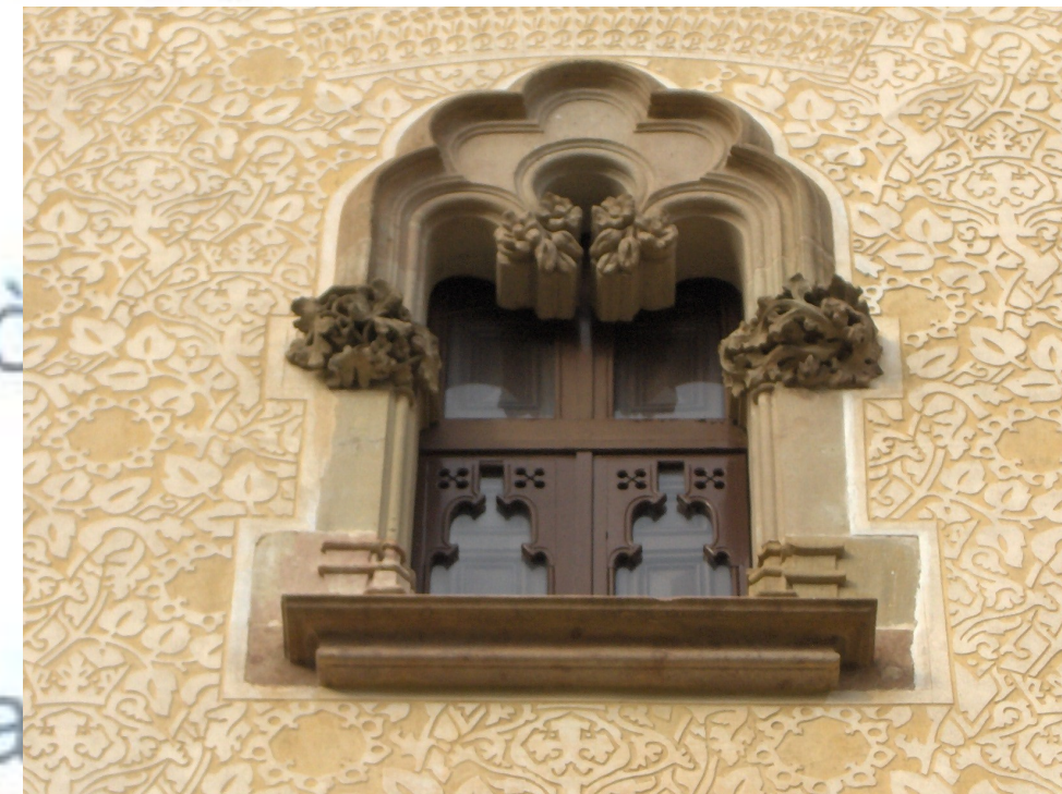
Finestra planta segona
