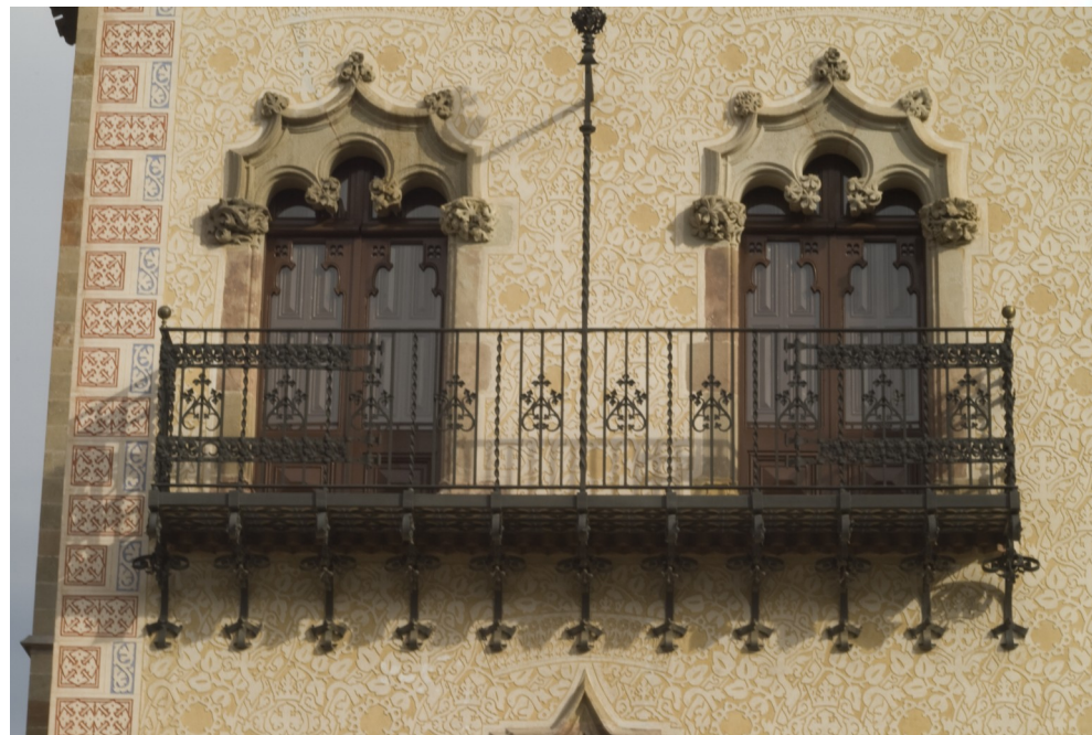
Balconera de planta segona
