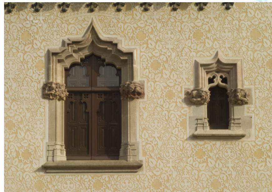
Finestres de planta primera
