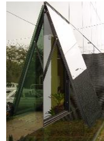
Ejemplo de ventana proyectable en muro cortina.
