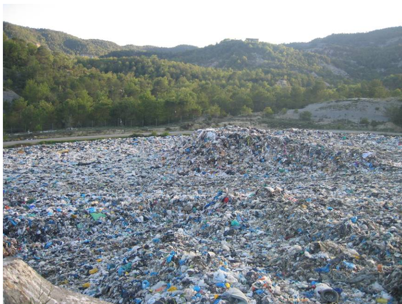
Fig. 4.11. Vaso del vertedero colmado
