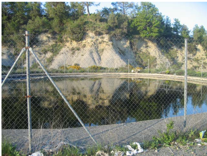
Fig. 4.14. Balsa de riego de lixiviados
