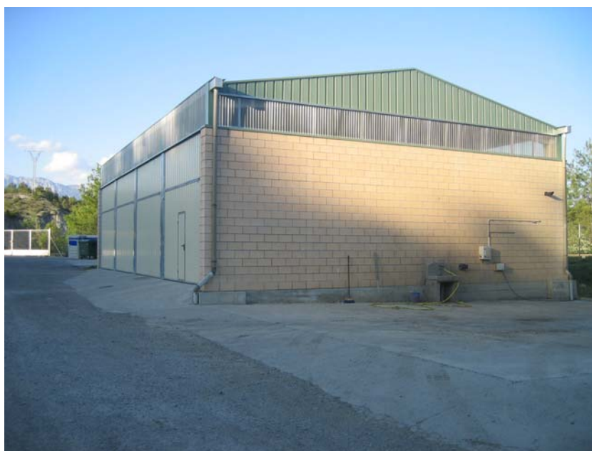
Fig. 4.10. Nave "B" y lavadero
