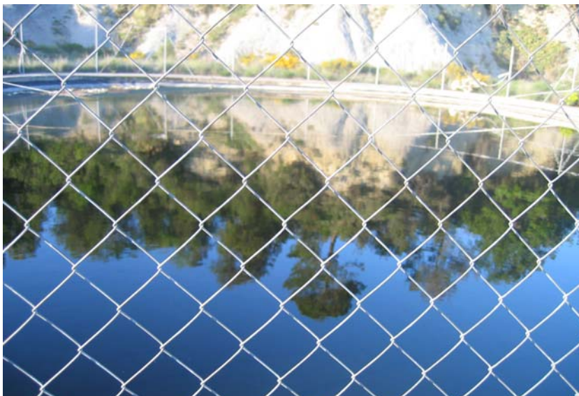
Fig. 8.5. Balsa de riego de lixiviados prácticamente colmada
