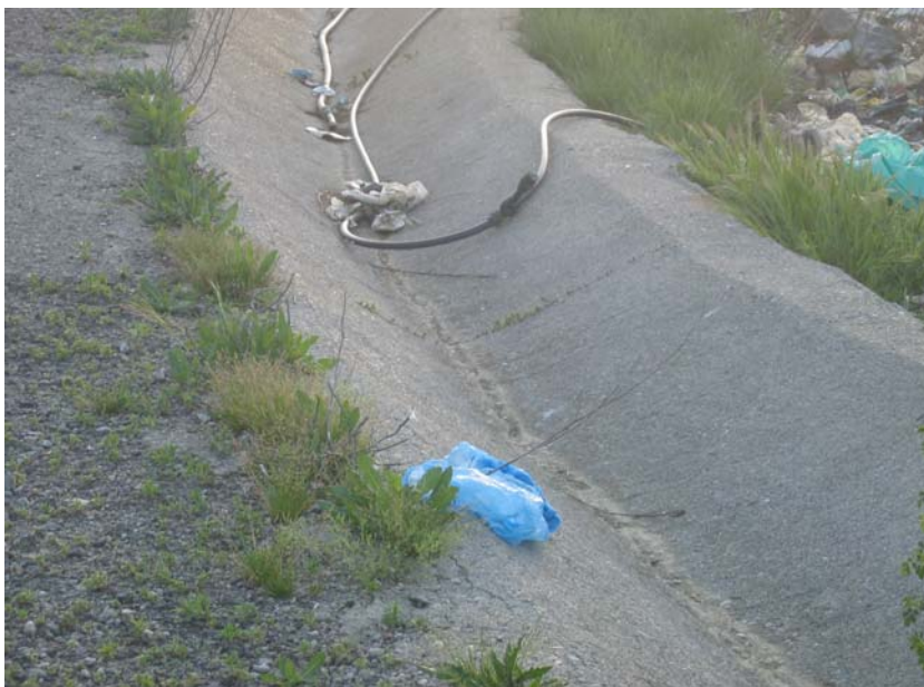
Fig. 4.16. Cuneta perimetral de hormigón
