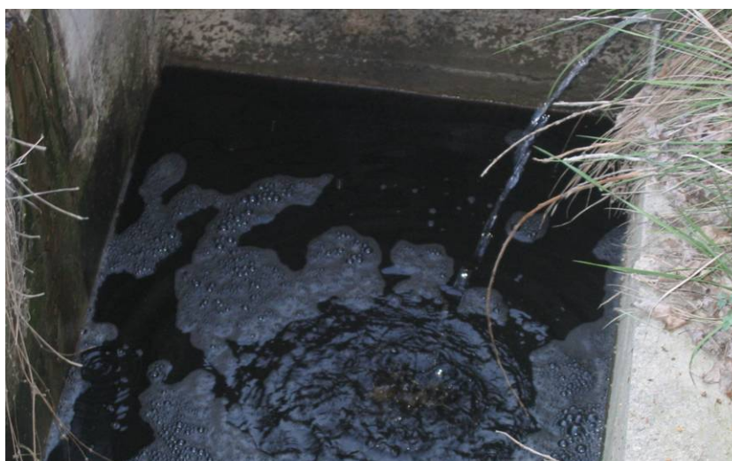
Fig. 8.1. Registro recolector de lixiviados del vertedero
