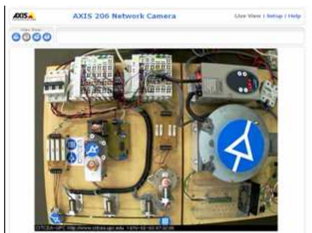
Fig. 6.12 Vista de la plataforma vía cámara IP. ETSEIB
