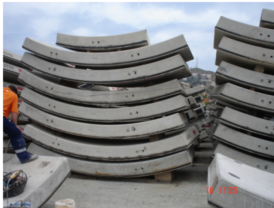
Fig. 4.5 Esquema d'apilament de les dovelles, L9 Barcelona
