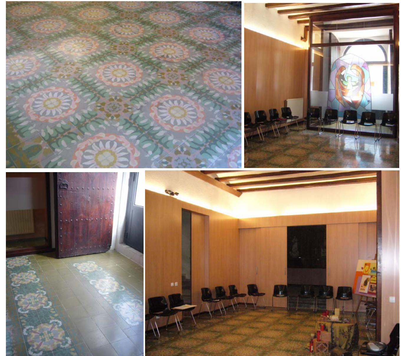
Estado actual del mosaico hidráulico de la Casa Escofet en la antigua entrada principal.
