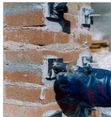
(d) Inserting anchorage devices
