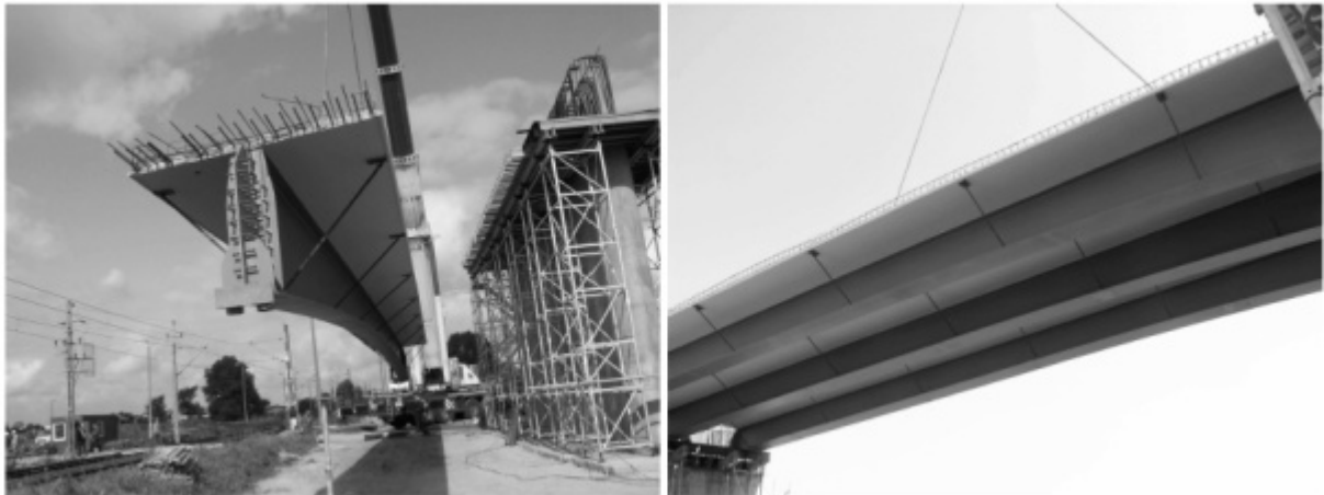
Fig. 9.4. VFT girder assembly (Elbląg– Akacjowa Street).
