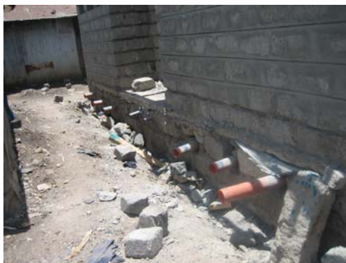
Desagües del bloque de saneamiento (izquierda) y la arqueta de control de la red de alcantarillado que pasa cerca de las nuevas instalaciones (derecha)
