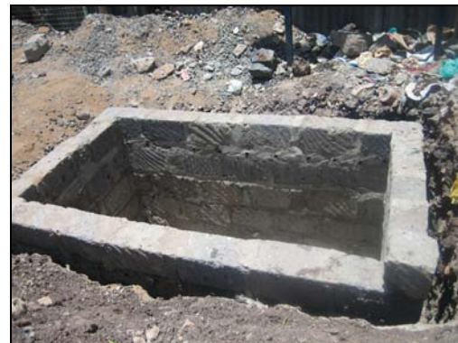
Arqueta principal para todo el asentamiento de Mukuru y la arqueta comunitaria en construcción
