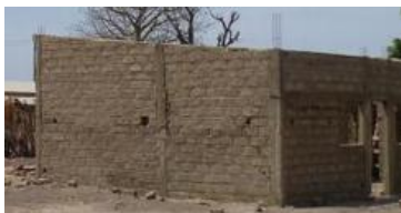
Figura 5.2.3.5. Vista exterior d'una edificació actual: mur exterior de bloc de ciment / revestiment amb morter de ciment
