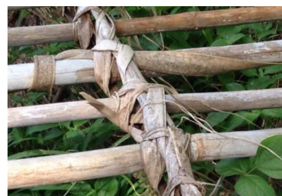
Figura 3.2.3.8. Lligat manual de les branques secundàries amb les branques principals de l'estructura d'coberta.
