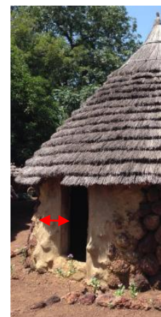
Figura 3.2.1.3. Construcció tradicional de pedra. Espessor del mur e=0,4m
