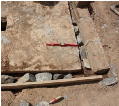
Figura 6.2.3.5. Reblert de pedra entre la sobre fonamentació de ciment i el forjat.
