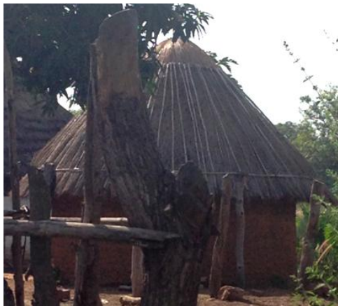
Figura 4.5.3.4. Construcció tradicional Fulani. Tècnica 2 de coberta.
