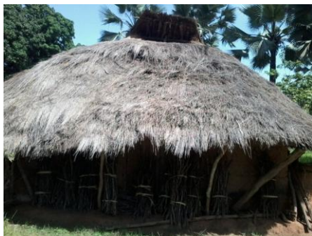
Figura 4.3.2. Maison effet venturi. Ayouné, Oussouye, regió de Ziguinchor, Baixa Cassamance. FONT: pròpia
