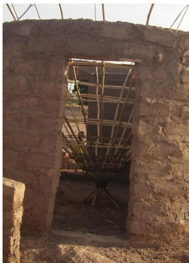
Figura 3.2.3.7. Lligat manual del conjunt de bigues amb corda i col·locació de les biguetes o branques secundàries.
