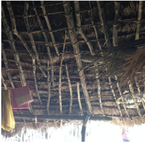
Figura 3.1.14. Vista interior de l'estructura de coberta.
