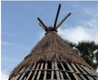
Figura 3.2.3.9. Detall del lligat de les canyes principals de coberta.
