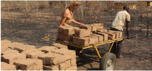
Figura 3.2.2.6. Transport del bloc d'adob fins la zona d'obres.
