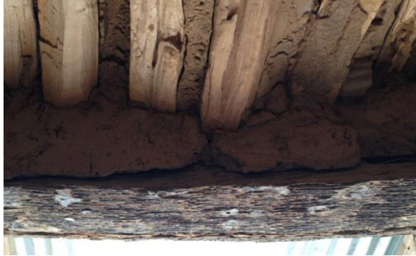
Figura 4.2.6. Emportament de les bigues principals del sostre al mur de façana.
