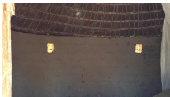
Figura 3.2.1.5. Obertures de ventilació. No presents en totes les edificacions.
