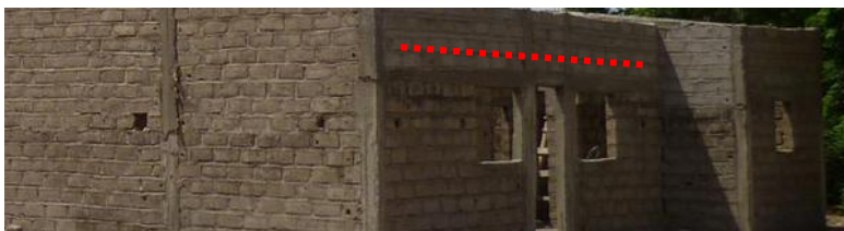
Figura 5.2.3.4. Vista exterior d'una edificació actual en construcció a País Bassari.
