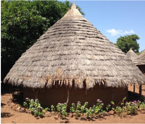
Figura 4.5.1.6. Construcció tradicional Bassari. Sistema muràri amb bloc d'adob amb un petit porxo perimetral conformat per la pròpia coberta.
