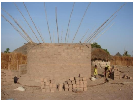
Figura 3.2.3.1 Replanteig del perímetre i construcció del mur d'adob / detall constructiu arrencada del mur.
