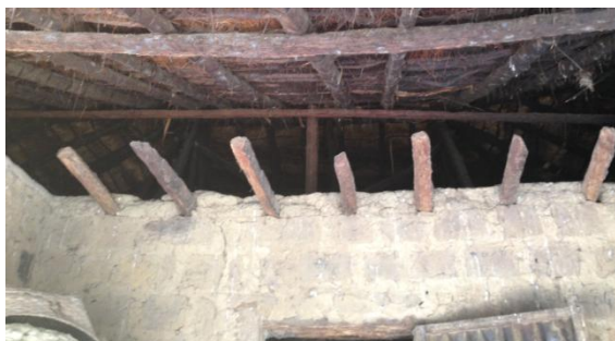
Figura 3.1.4. Vista frontal de l'estructura de coberta i el forjat superior.
