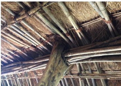
Figura 3.2.4.1. Biga confeccionada amb canyes de bambú
