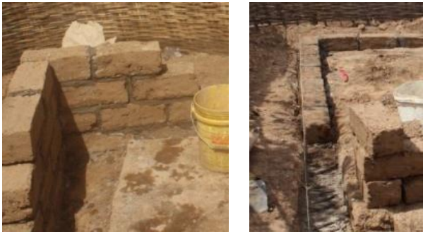
Figura 6.2.3.4. Execució de cantonada / execució primera filada (respectivament)
