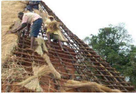
Figura 3.1.13. Execució de l'acabat de coberta amb palla d'arròs en una edificació murària s'obra d'adob a Benin.
