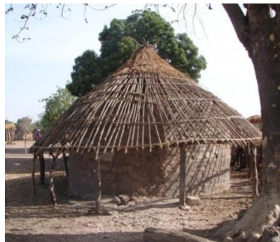
Figura 3.2.3.10. Estructura de coberta d'una construcció típica a País Bassari recolzada sobre pilars
