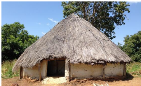
Figura 4.5.3.5. Construcció tradicional Fulani amb doble mur.
