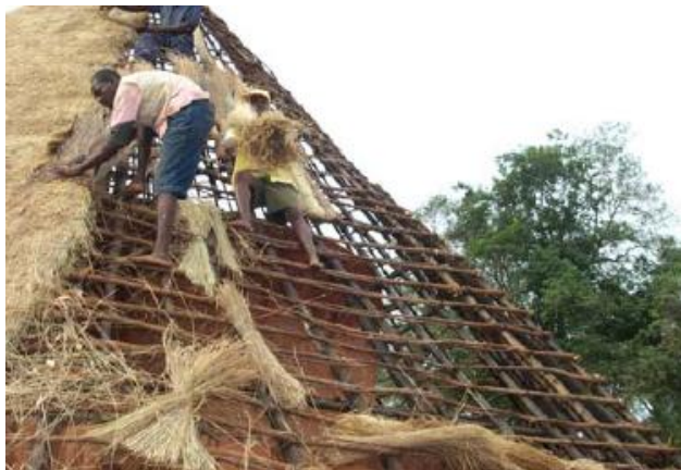
Figura 4.2.3.8. Construcció d'una coberta de fusta i palla a Benin Bigues principals de fusta i biguetes de bambú africà.
