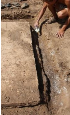
Figura 6.2.3.2. Excavació de rases de fonamentació FONT: Institut Jane Godall(IJG) , Departament de Bio, Senegal.
