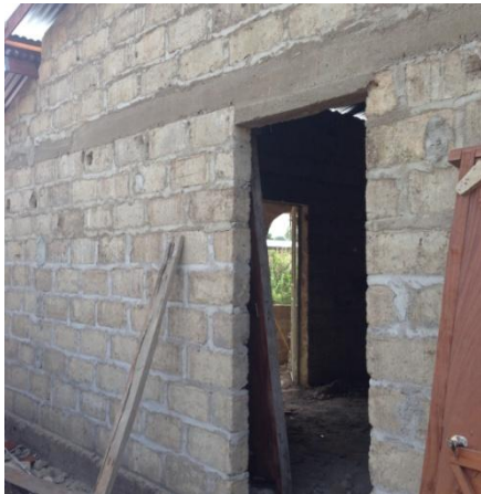
Figura 8.3.3.4. Construcció amb bloc de formigó. e=10cm
