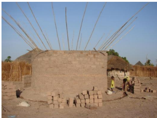
Figura 3.2.3.6. Col·locació de les branques principals (bigues) de la coberta segons la tradició constructiva [esquerra] / Detall de la disposició de les branques [dreta]
