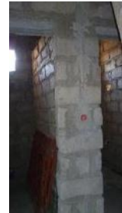
Figura 5.2.3.3. Divisòria interior doble de bloc de ciment.
