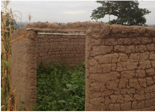
Figura 4.5.2.5. Construcció d'un mur.
