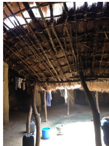
Figura 11.2.3.9. Casa impluvium, coberta interior.
