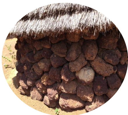
Figura 4.5.1.5. Detall de la confecció del mur. Sistema muràri amb pedra.
