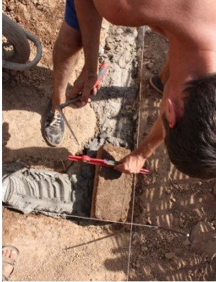
Figura 8.3.3.2. Fonaments de la construcció actual realitzada per ONGD FONT: Institut Jane Goodall (IJG), Departament de Bio construcció, Senegal.
