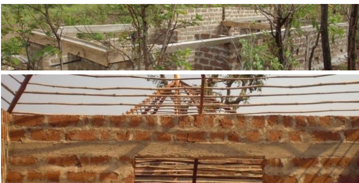
Figura 6.2.3.6. Utilització d'encofrats de fusta per a l'execució de dintells continus de morter de ciment.
