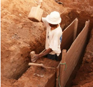
Figura 4.2.2.3. Construcció d'un mur de Tapial al Col·locació de l'encofrat de tapial, M'Hamid El Ghizlane. FONT: Associació Terra Chidia, www.tierrachidia.es
