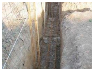
Figura 5.2.3.1 Fonamentació de la construcció actual a País Bassari. Execució de rases i col·locació de barres d'acer corrugat, previ replanteig dels fonaments.
