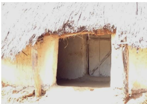
Figura 3.2.1.4. Doble mur. Espai amortidor.
