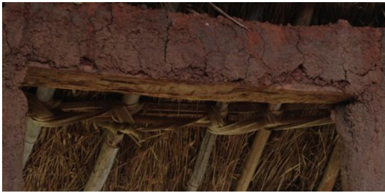
Figura 3.2.3.3. Peça dintell confeccionat amb fusta. Construcció Bedik, País Bassari.
