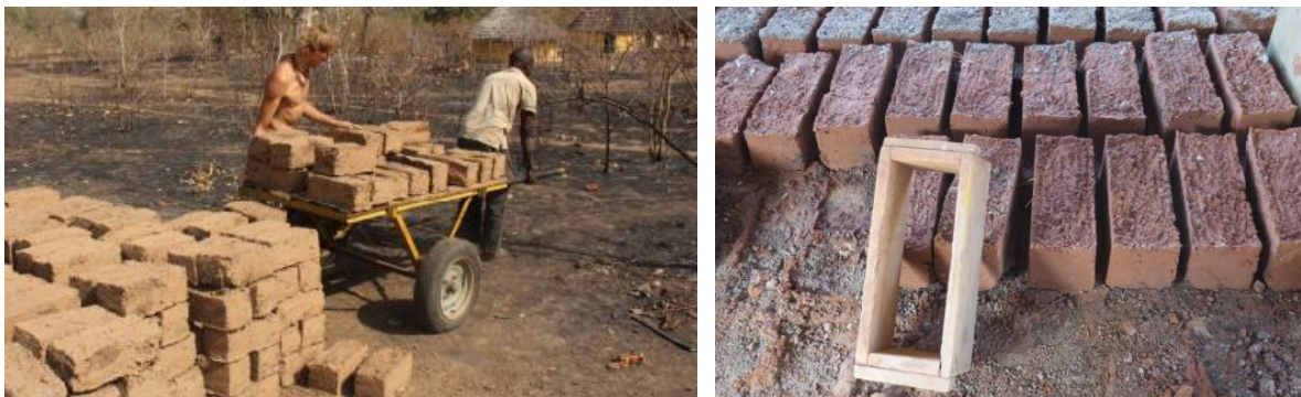
Figura 6.2.2.1. Transport dels blocs d'adob amb carreta i acopi de blocs posterior a l'assecat dels mateixos. FONT: Institut Jane Goodall (IJG) , Departament de Bio, Senegal.
