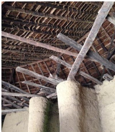
Figura 4.1.5. Vista interior zenital; estructura de coberta, forjat superior de les estances.
