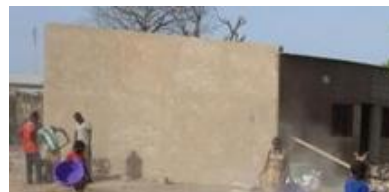
Figura 5.2.3.5. Vista exterior d'una edificació actual: mur exterior de bloc de ciment / revestiment amb morter de ciment
