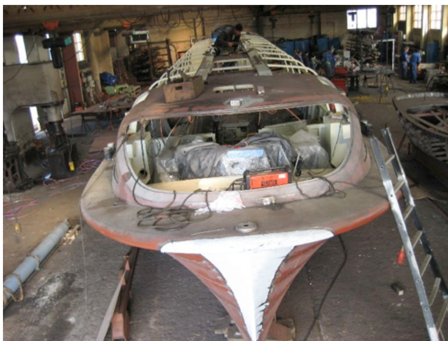
Figura 7.17: Construcció H2Nemo. Font: Rederij Lovers
