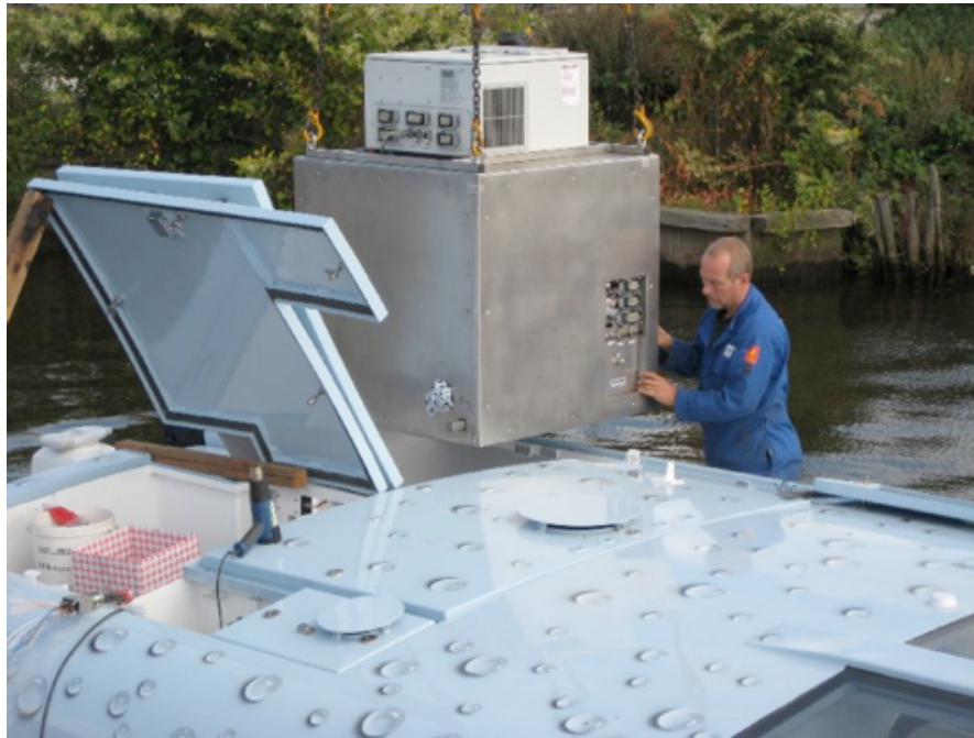
Figura 7.18: Instal·lació unitat PEMFC a H2Nemo. Font: Rederij Lovers
