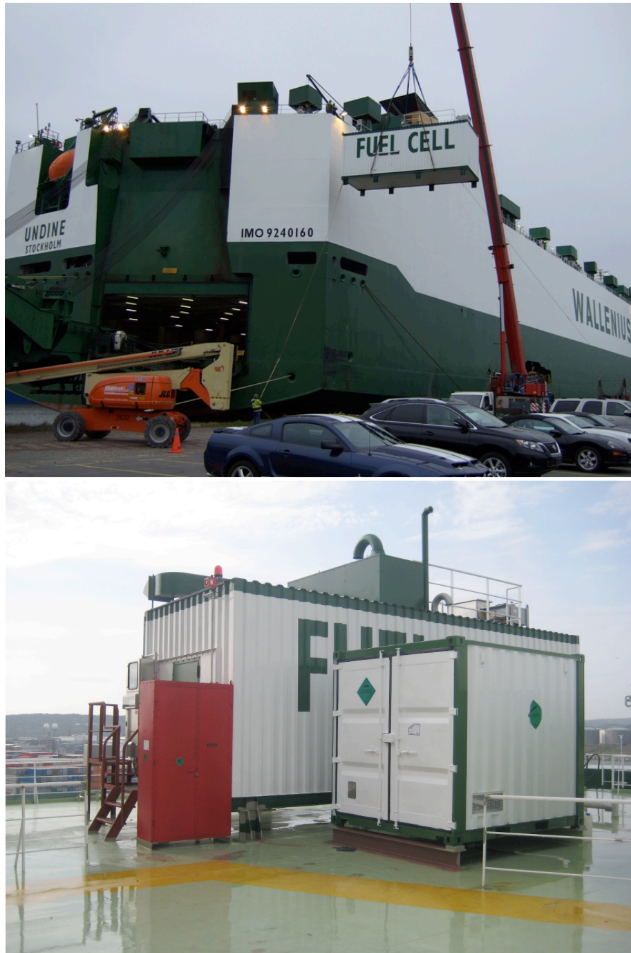
Figura 7.22: Instal·lació unitat SOFC a bord. Font: METHAPU
