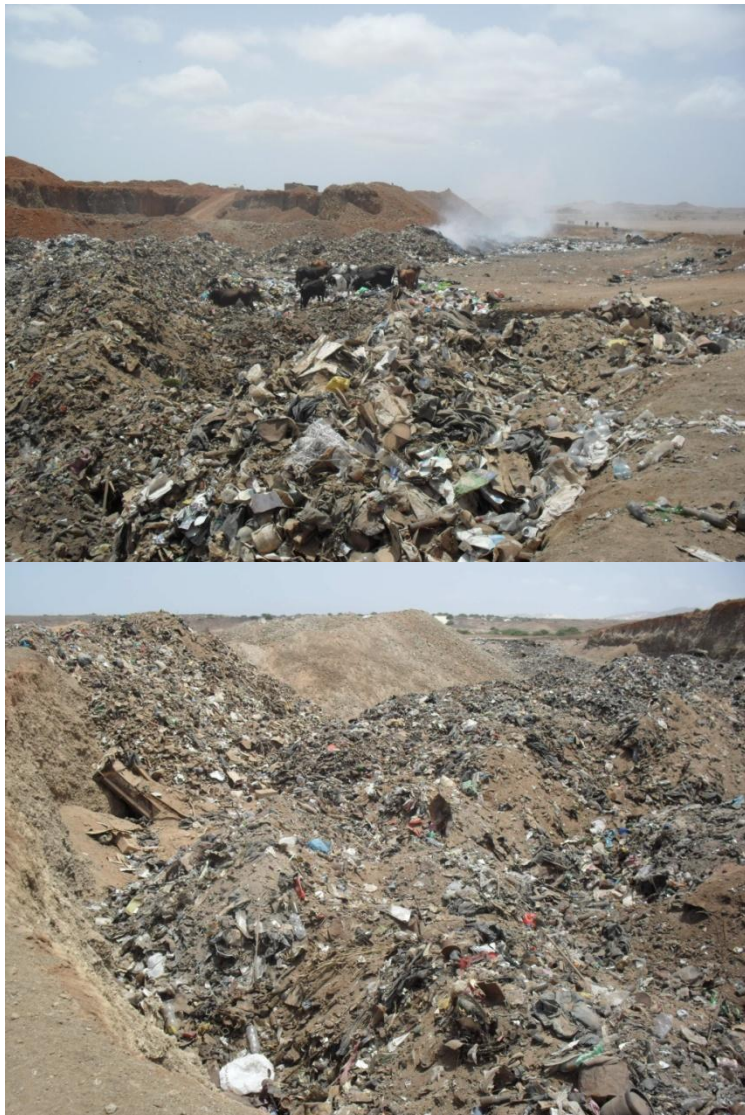
Imagen 1a y 1b. Dos ejemplos de la colocación de modo 1 en “zanjas”
