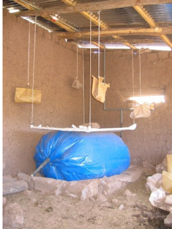
Ilustración 6-3 Bolsa plástica acumuladora de biogás, con sistema para aumentar la presión.
