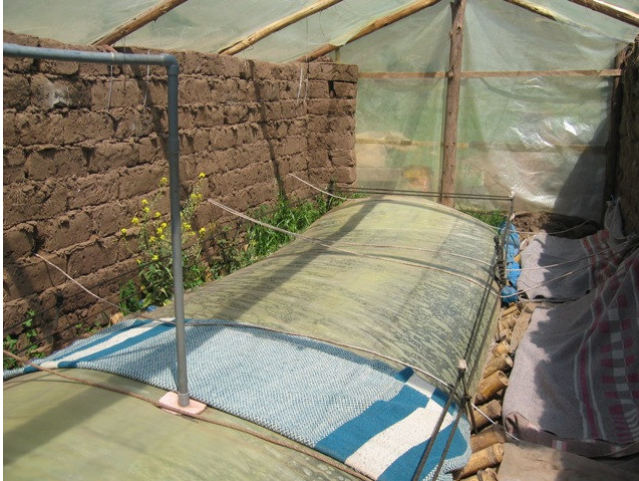
Ilustración 6-2 PTD de Chollocani instalado bajo invernadero, y sistema de cubiertas móviles, mandadas desde el exterior por seguridad.
