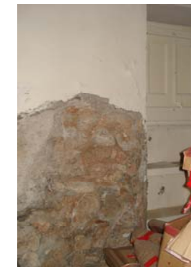
Mur de maçoneria.
