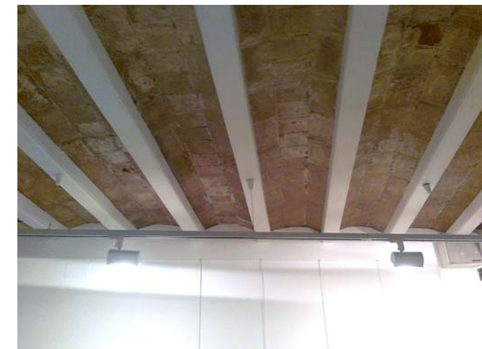
Sostre de PB format per biguetes de fusta i volta de rajola
