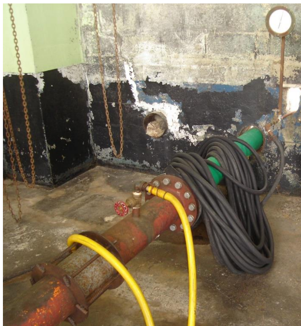
Figura I. 3. Conexión de salida del pozo 3
