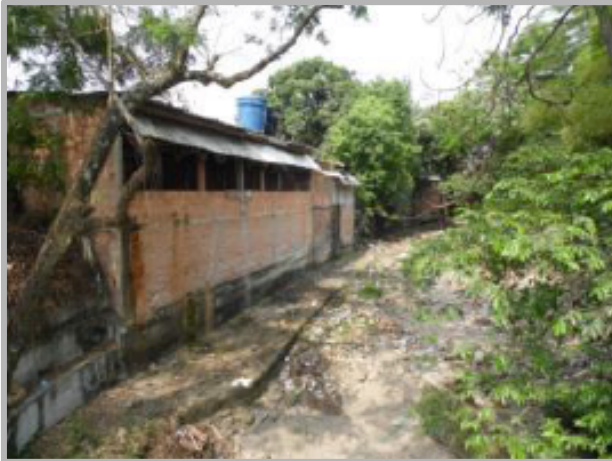
Figura 18: Vista puente peatonal.
