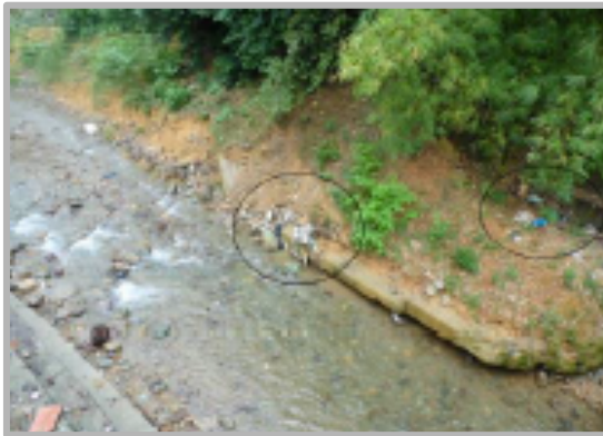
Figura 20: Vista aguas arriba puente sexta etapa. Fuente: (Contraloría municipal Villavicencio , 2010 )
