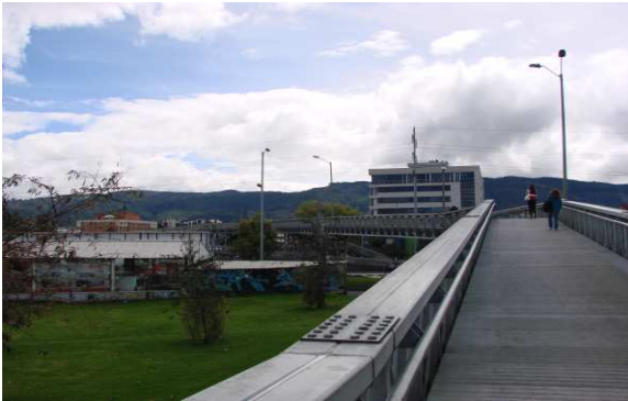
Presencia de lotes baldíos cerca de las estaciones y puentes peatonales que generan dinámicas de inseguridad
