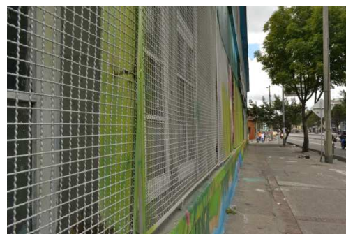
Colegio Manuela Beltrán – Fuente: registro fotográfico propio
