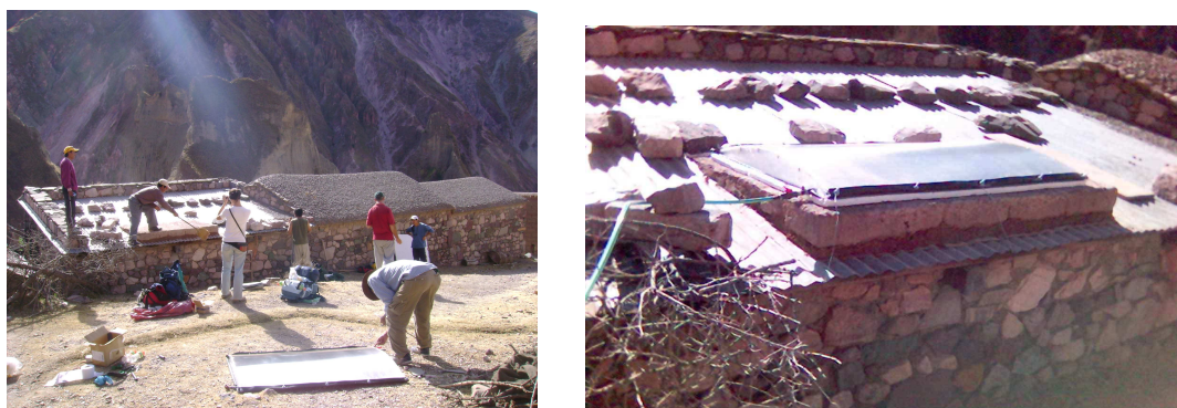
Figura 6: Base nivelada para el colector instalado en el techo de una vivienda.
