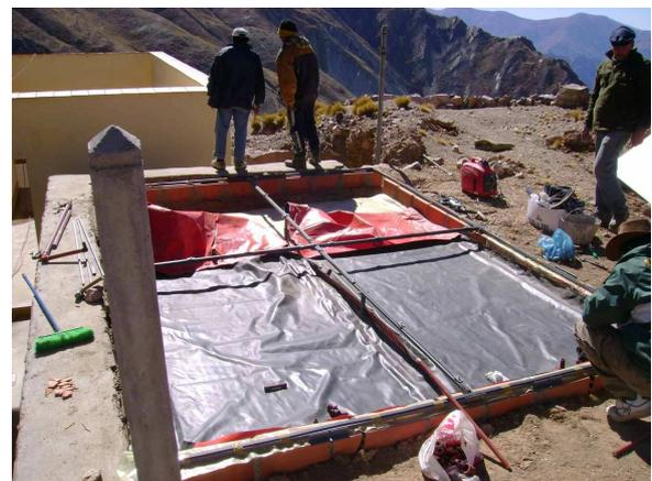
Figura 5.: a) Estructura de caño. b) Colocación de las bolsas de PVC sobre el aislante térmico.
