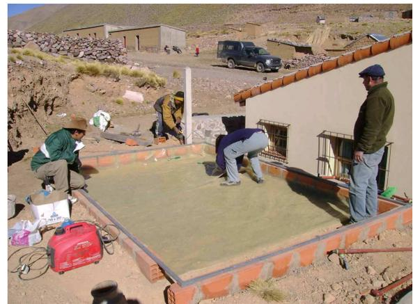
Figura 4.: a) Construcción del cordón perimetral. b) Colocación del plástico de invernadero sobre el suelo apisonado.
