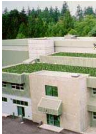
Figura 2. Techo verde del edificio
