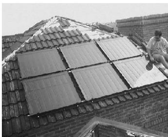
Figura 1: Presentación de los colectores durante el montaje
