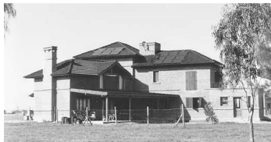
Figura 3: Vista NO de la instalación completa, con los 15m<sup>2</sup> orientados al Norte con una inclinación de 30°
