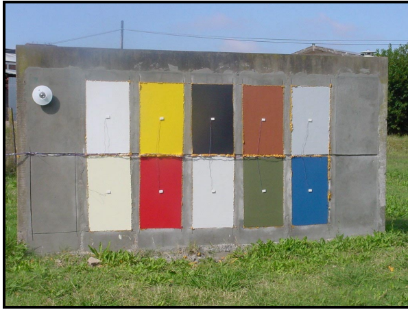
Figura 4. Muro sobre el que se realizaron las mediciones de temperatura superficial.
