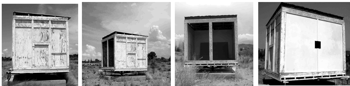
Figura 2. Vista exterior del dispositivo de ensayos, ubicado en el predio del CRICYT, en su estado inicial.
