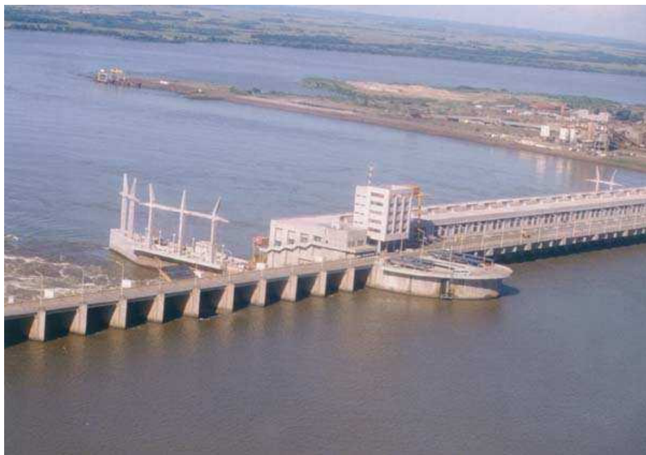
Figura 2.- Vista aérea de la Central Yacyretá y vertedero principal
