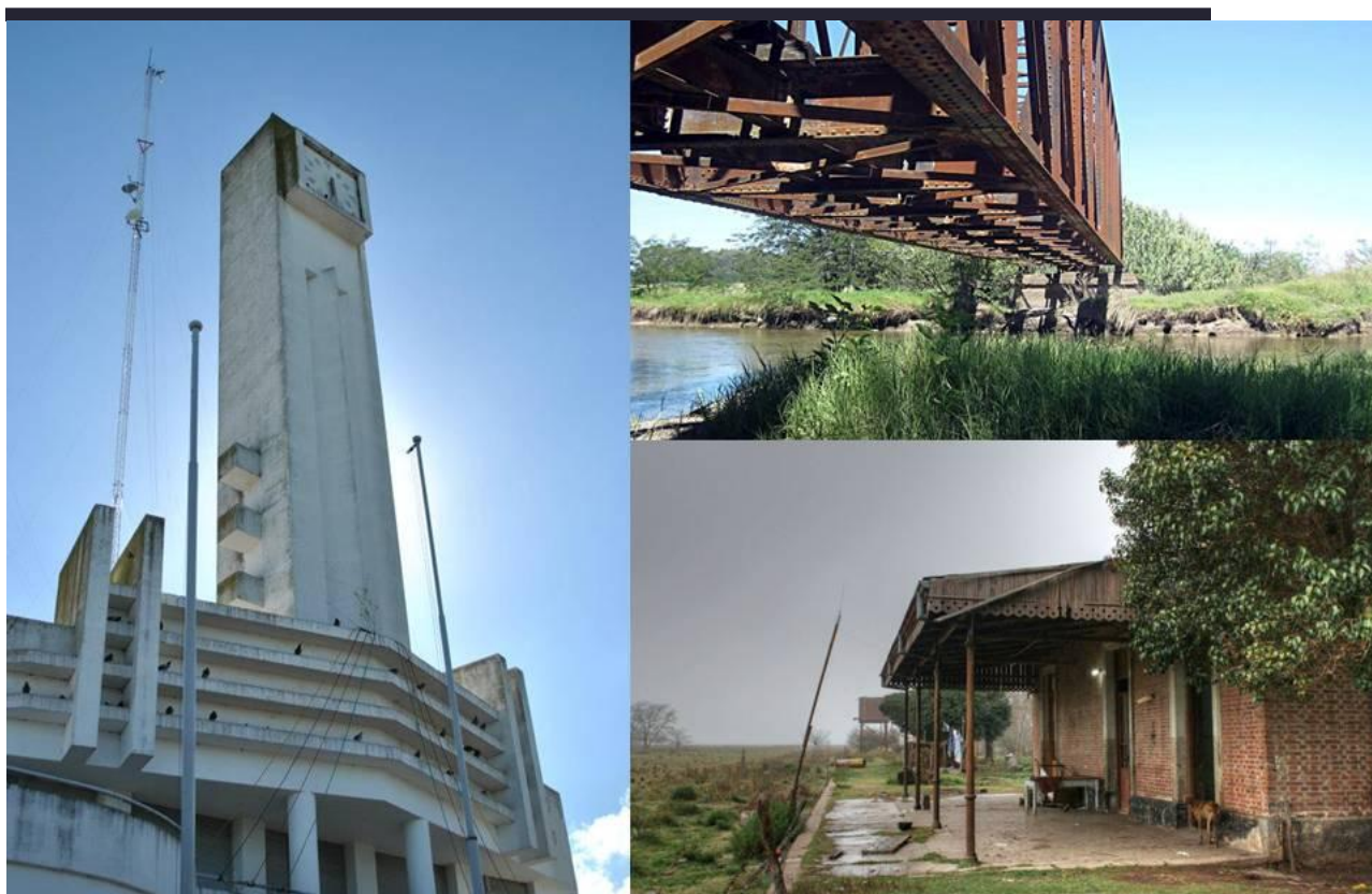
Arquitectura patrimonial de los pueblos de la región NOBA. Fuente: sitios web referenciados.
