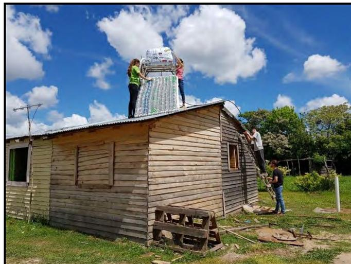
Figura 2.- Instalación del calentador solar
