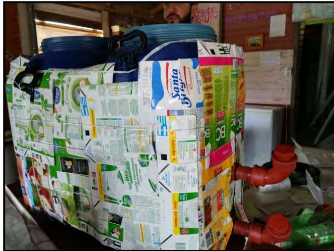
Figura 1.- Tanque de almacenamiento del calentador solar
