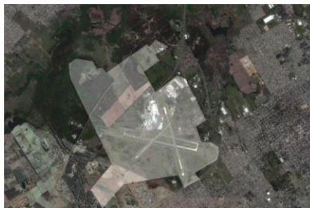
Figura 29: Inserción del aeropuerto en el entorno. Fuente: Google Earth
