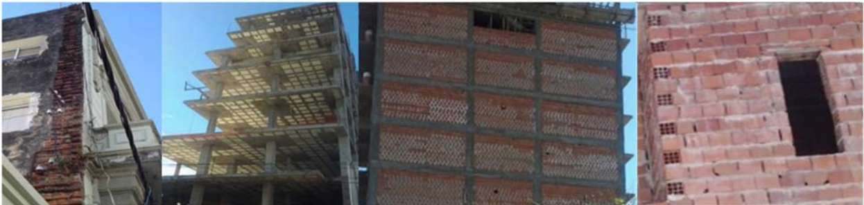
Fig. 4: Edificios en Altura en Argentina: hasta 1960 perímetros portantes macizos (izquierda); Desde 1970, con esqueletos estructurales; Desde 1980 con cerramientos de ladrillos huecos y losas alivianadas (centro), bajo acciones climáticas naturales: temperatura del aire y viento. Cerramientos constructivos perimetrales (derecha), sin sellado de las juntas verticales de los mampuestos huecos, quedando secciones transversales con aire y solamente cubiertas por los revocos superficiales. Fuente: JACOBO, 2016 y 2017.
