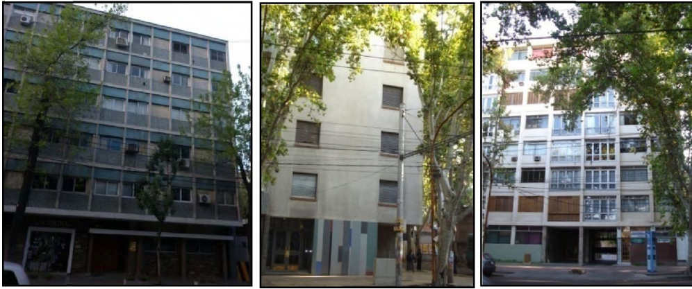
Figura III.12. Edificios sin retiros, entre 5 y 7 niveles de altura sin elementos salientes de protección en las fachadas
