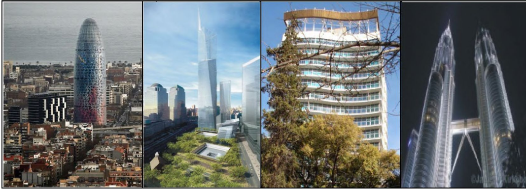
Figura 1.3. Edificios en altura con resoluciones similares de envolvente, en su mayoría transparente en Barcelona, Nueva York, Mendoza y Kuala Lumpur
