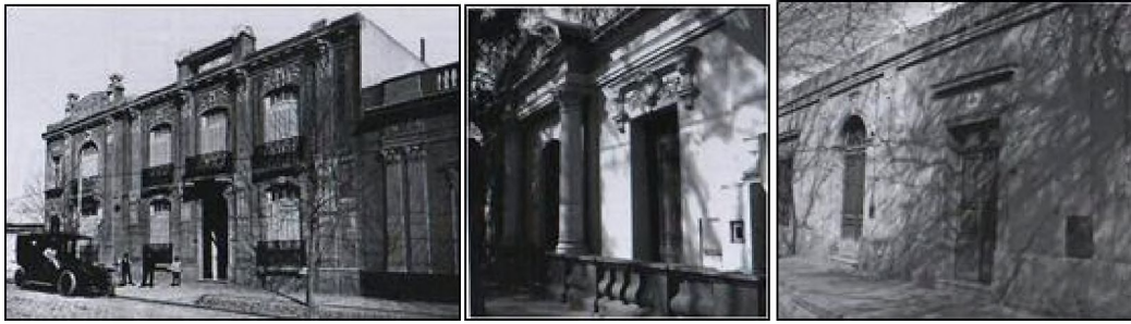
Figura III.1. Viviendas de una y dos plantas de adobe al ras de la línea de edificación
