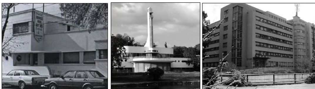
Figura III.9. Construcciones influenciadas por el Movimiento Moderno europeo
