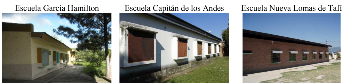
Figura 25: Vistas exteriores del sector de las aulas de las escuelas
