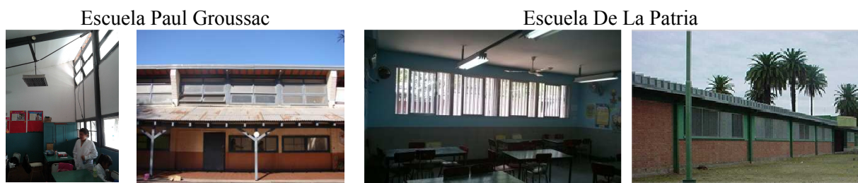
Figura 24: Vistas interiores y exteriores de las aulas
