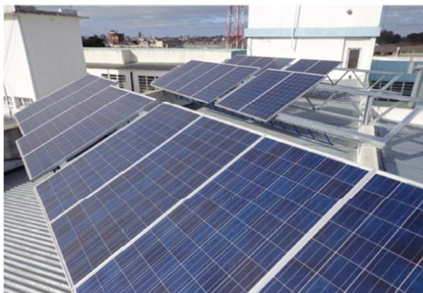
*Figura 3: Planta piloto FV en la terraza del edificio FI-UNMDP (inclinación de panel 30°)*
