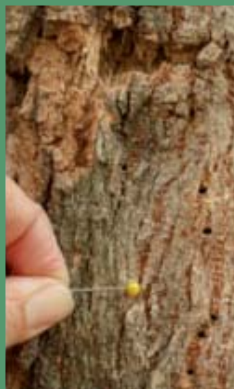
Foto 2. Orificios de salida alineados en las ranuras de la corteza causados por Xyleborus .
