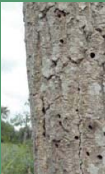
Foto 1. Orificios de salida de forma irregular sobre la corteza causados por Tremex .
