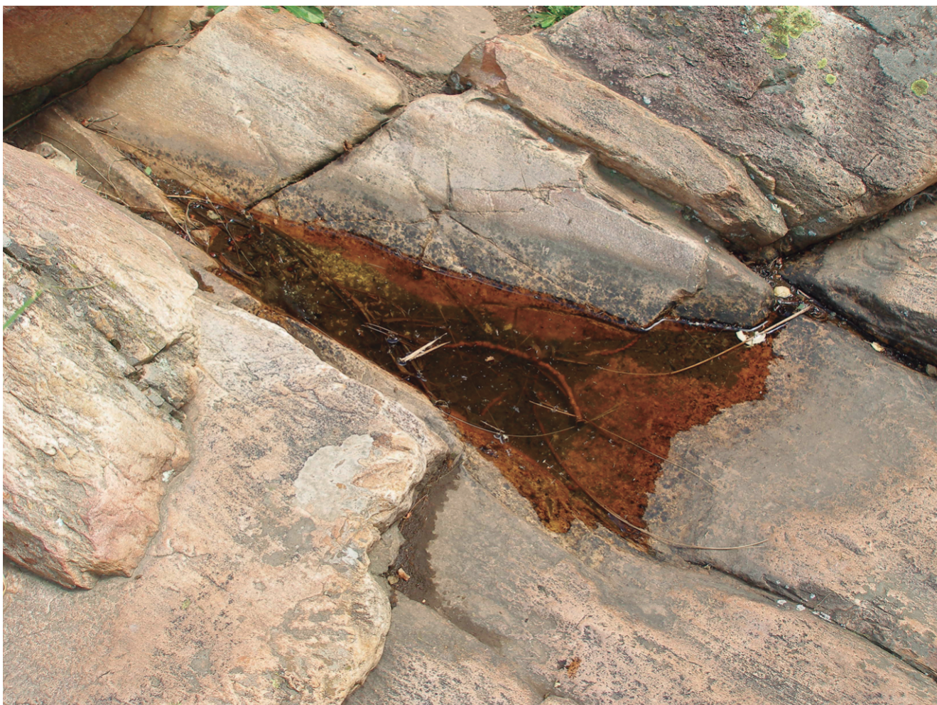
Figura 8. Hueco en roca.
