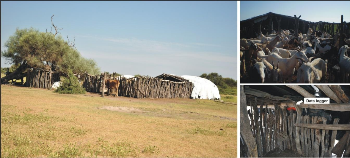
Figura 3-5 Peridomicilio de la provincia de Chaco. Vista general. Der-abajo: “data logger” colocado entre los palos a pique y el recubrimiento exterior de plástico.
