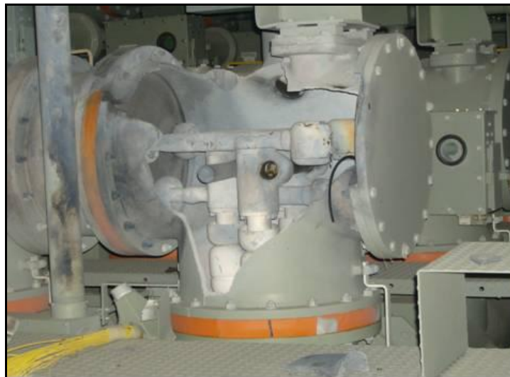
Fig. 3. Seccionador dañado
