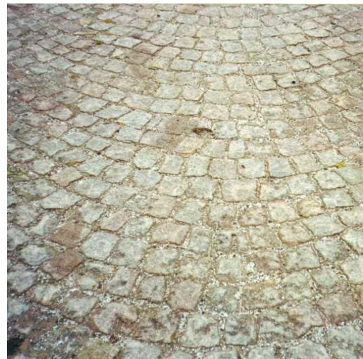
Fig. 6. Detalle de calzada mostrando el revestimiento.
