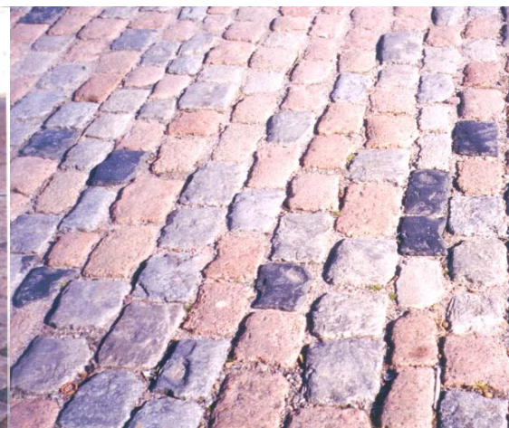
Fig. 8. Detalle del empedrado.
