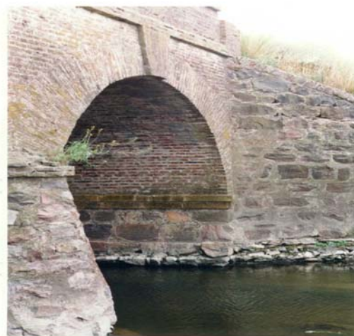
Fig. 2. Detalle del puente de Azul mostrando revestimiento de los estribos.
