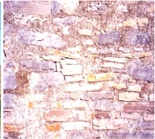
Fig. 10. Detalle de vivienda.
