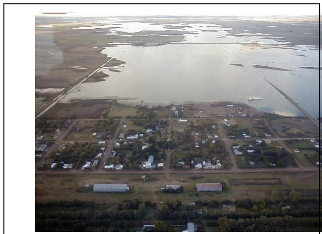
FIGURA 3 Fotografía de la localidad de Pincén tomada desde sobrevuelo al área afectada por las inundaciones, el 04 de mayo de 2001.
